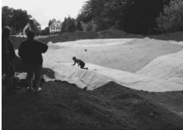
Fig. 5: Most of the 39 ponds were sealed by foil to maintain permanent water bodies. Die Mehrzahl der 39 Teiche wurde mit Folien abgedichtet, um eine ganzjährige Wasserführung zu gewährleisten.
