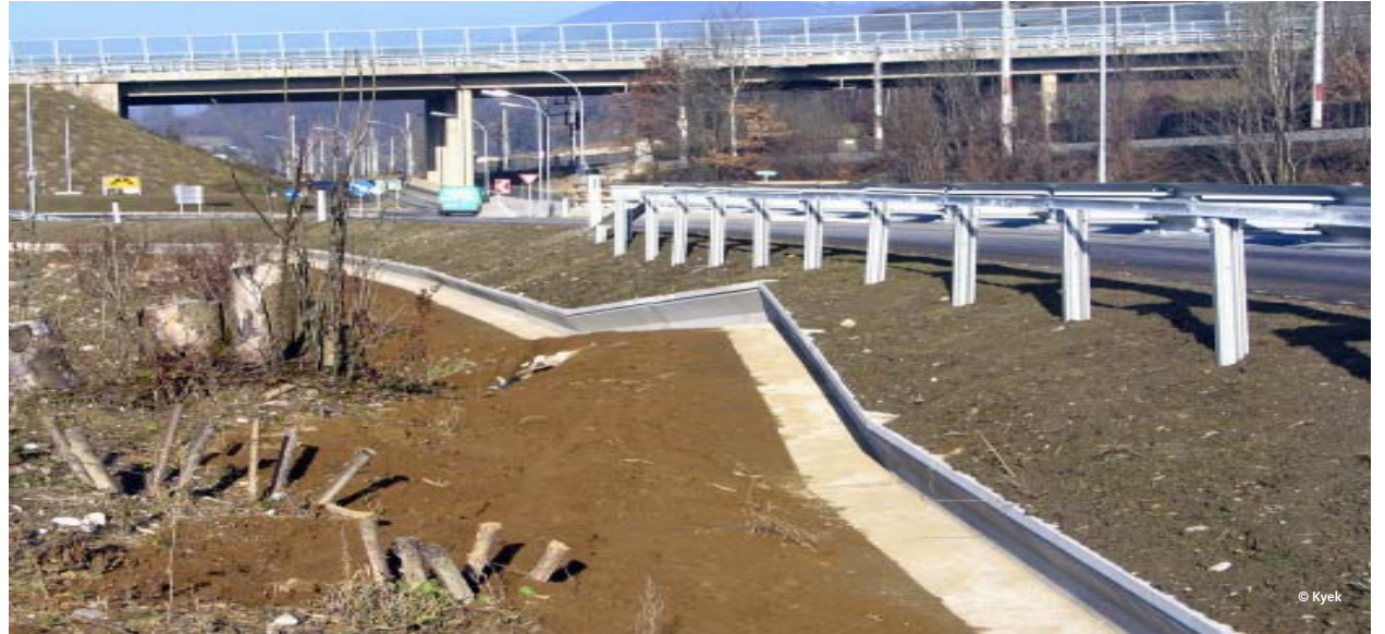
Tunnelleitanlagen lassen sich am einfachsten bei der Neuerrichtung von Straßen mitplanen. Sie verhindern, dass Kleintiere auf die Straße gelangen
