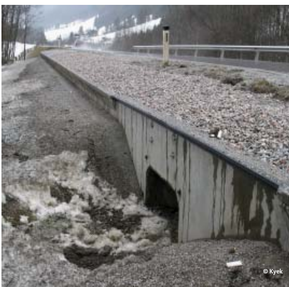
Tunnelleitanlage mit Unterführung zum Schutz von Kleintieren
