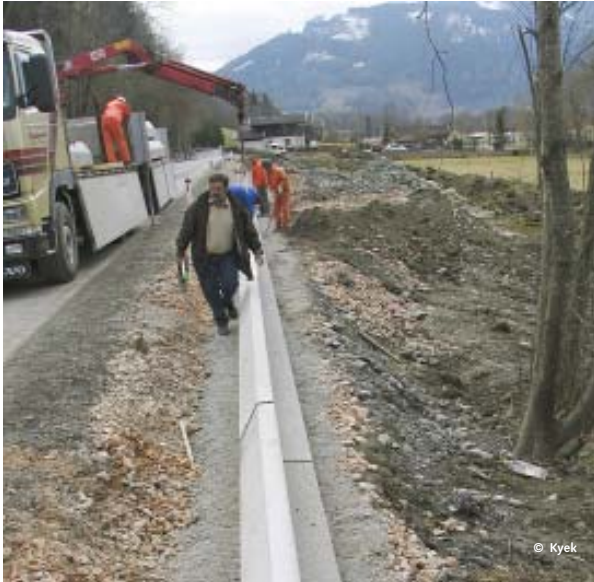
Tunnelleitanlage in Bau – damit kann die Straße gefahrlos unterquert werden
