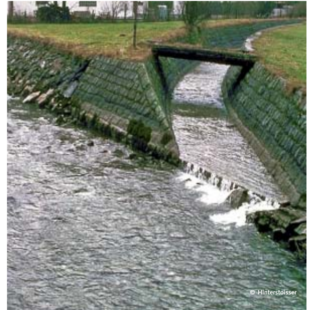
Zerstörung von Lebensraumstrukturen, z. B. durch die Verbauung von Fließgewässern
