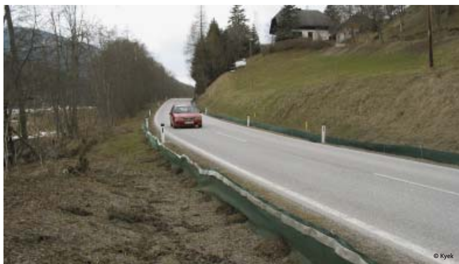
Straßen durchtrennen die Lebensraumteile von Amphibien. Hier sieht man eine mögliche Schutzmaßnahme: einen Amphibienzaun entlang der Straße
